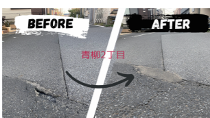
道路の陥没箇所の 補修
