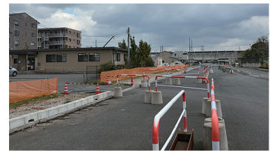
整理中の新田駅西口周辺
